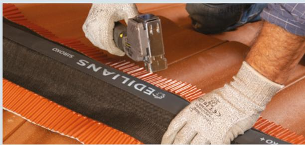
2- Fixer le closoir au niveau de la bande de renforcement à l'aide d'agrafes ou de pointes.
