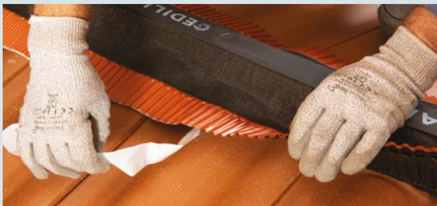
3- Retirer la bande de protection butyle à l'avancement, presser et maroufler les bavettes sur les tuiles.
