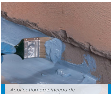
Application de Mapeband sur un joint d'angle avec Mapelastic AquaDefense
