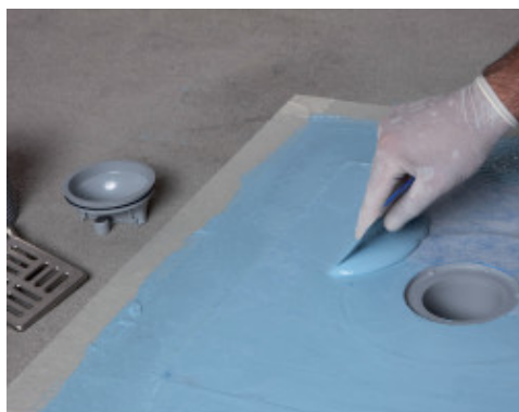
Imprégnation d'un produit Drain Vertical avec Mapelastic AquaDefense
